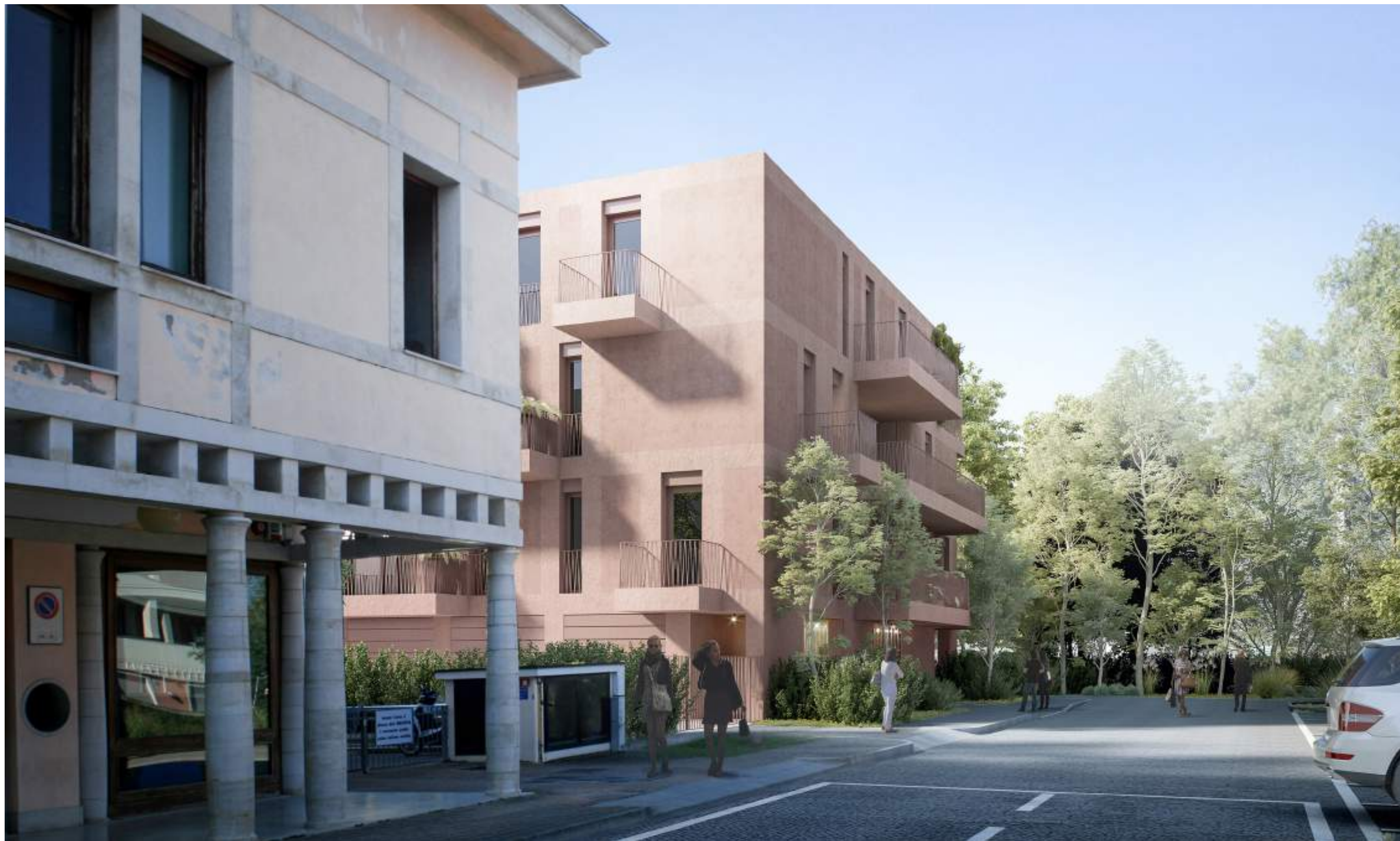
VISTA DALLA BIBLIOTECA
